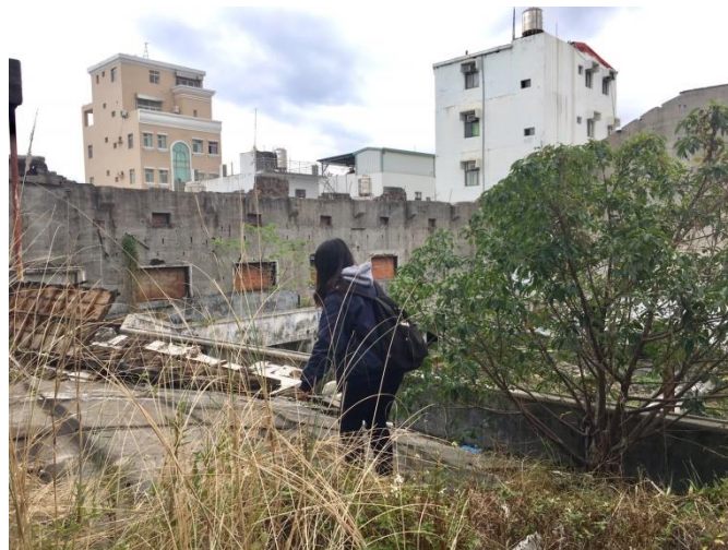
大同戲院的二樓，我腳下踩的是塌下來的天花板。
